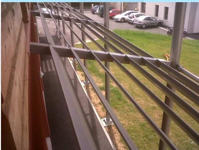
*Les protections solaires permettent de limiter les apports solaires dans les bâtiments. Ces solutions sont soit fixes ou mobiles, soit intérieures ou extérieures. Ensuite elles se déclinent en différentes formes, couleurs et matières, certaines pouvant parfois être réalisées grâce à de la végétation.*
